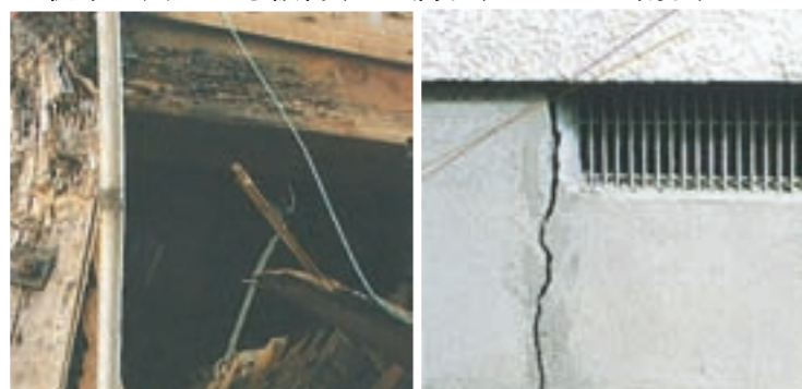
■従来工法による被害(左：腐れ、右：ヒビ割れ)
