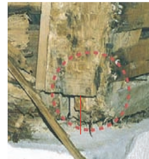
土台・柱脚部の腐朽が見られます。通し柱の柄が横にスライドし、土台小口を破壊してしまい、外れかけています。
